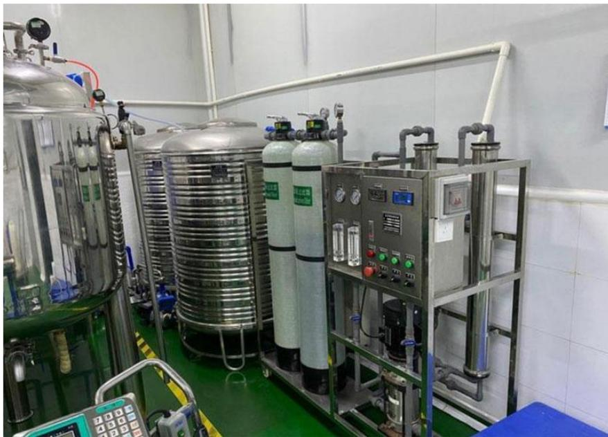
在电子制造工厂,芯片等精密电子元件的生产对水质要求极高,水中的微小颗粒、重金属等杂质都可能导致电子元件短路或性能下降。净水器通过反渗透等先进的过滤技术,能够去除水中几乎所有的杂质和有害物质,提供高纯度的超纯水,满足电子制造的特殊用水需求,确保产品的质量和良品率。
